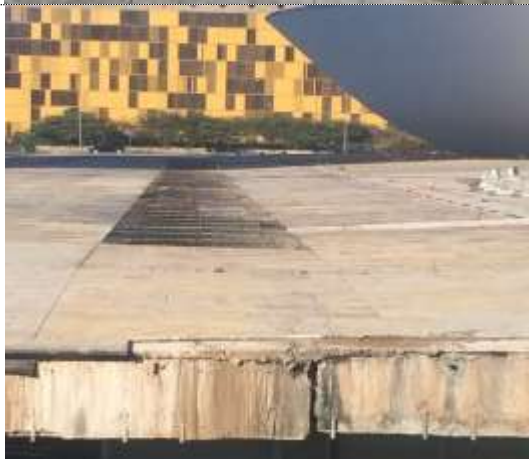
Fotografia 30: Vista da lateral da laje, onde destacamos a presença da junta de dilatação;
